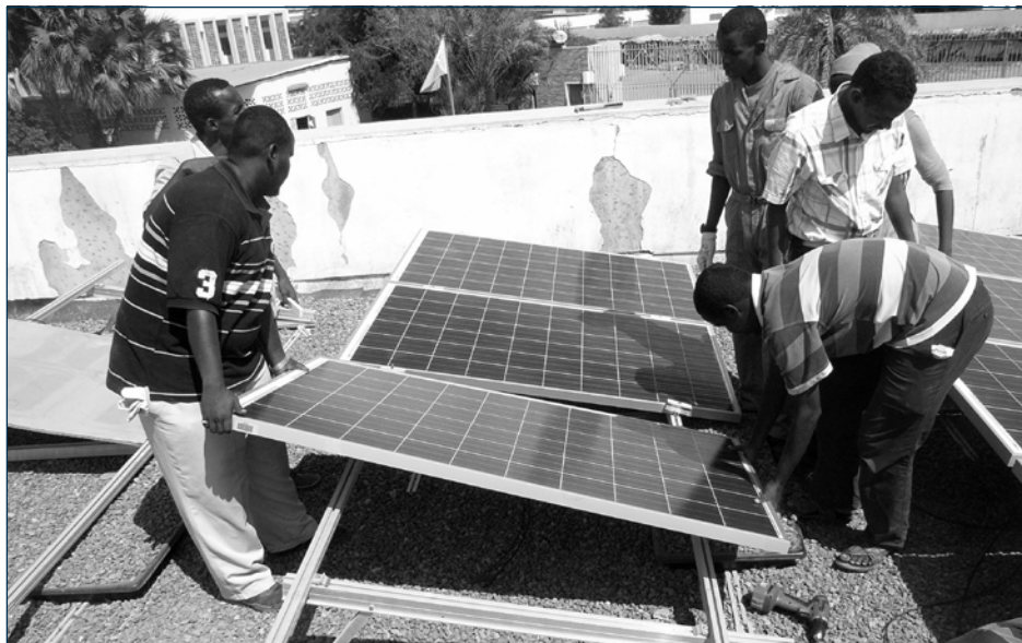
Installation einer Photovoltaikanlage im Rahmen eines BBP-Projekts in Dschibuti
