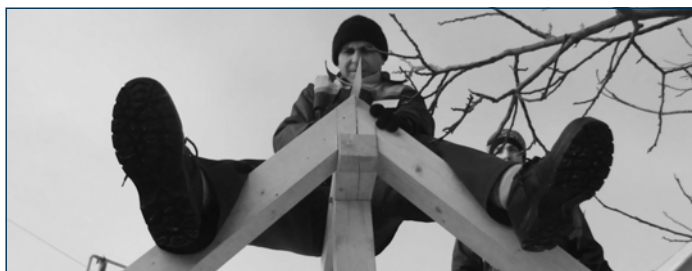
BBP-Projekt der Kreishandwerkerschaft Hersfeld-Rotenburg in der Republik Moldau: Zimmerer erlernen den Fachwerk- und Dachstuhlbau
