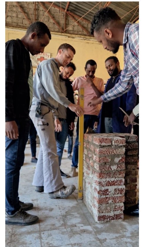
Auszubildende kontrollieren das Mauerwerk
