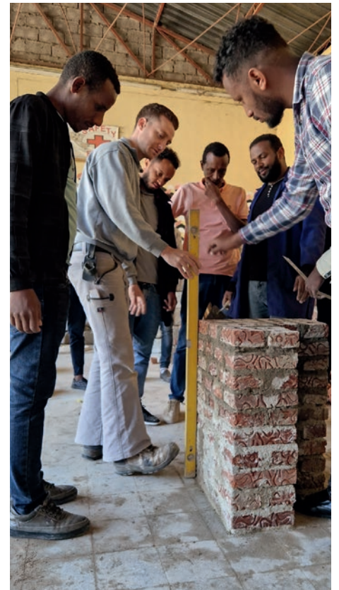
Auszubildende kontrollieren das Mauerwerk
